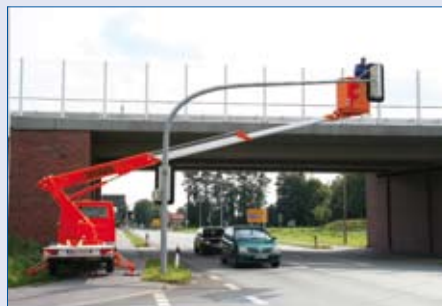
Verkehrssicherungsarbeiten bei fließendem Verkehr
