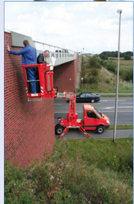
Inspektion und Wartung von Brücken
